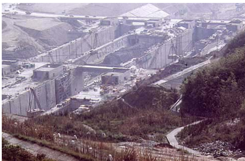
Pogled na gradilište prevodnica
