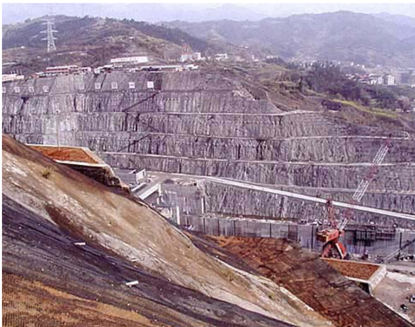
Zaštita pokosa gradilišta
